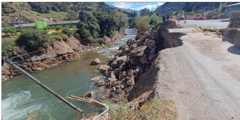
FIGURA N°03: Tramo del Río Huallaga donde se evidencia una severa erosión de la margen derecha, afectando directamente una vía de acceso. Se aprecian grandes bloques de roca en el lecho y el flujo del río, indicando la fuerza erosiva del caudal.
