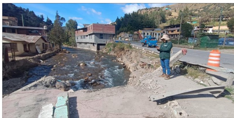
FIGURA N°02: Panorámica del Río Huallaga en zona urbana/semiurbana, con el cauce bordeando una vía principal y edificaciones. Se observa la margen derecha del río con material acumulado y posibles daños en la infraestructura vial adyacente.
